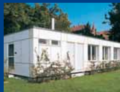
Pour ce jardin d'enfants, l'habillage extérieur a été réalisé en plaques de façade Pelicolor-Eternit
