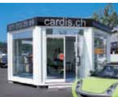
Pavillon de bureau de forme octogonale, constitué de 2 modules, permettant le déménagement aisé d'un endroit à un autre
