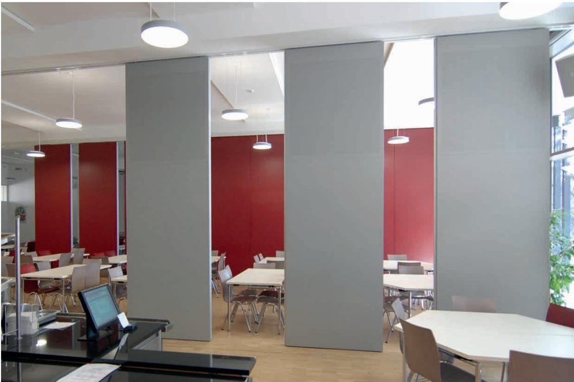
Die schalldämmenden und beweglichen Einzelelemente bieten Ihnen grosse Flexibilität, um schnell multifunktionale Räume zu gestalten. Die intelligenten Mobilwandlösungen sind in Deckenschienen und ohne Bodenführung verfahrbar. Daher sind sie ideal für tägliche Veränderungen innerhalb weniger Minuten.
