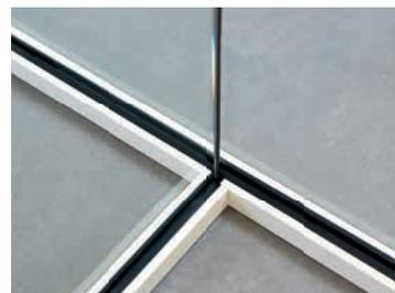
T-Anschlüsse vollständig aus Glas
