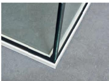
Eckanschluss vollständig aus Glas
